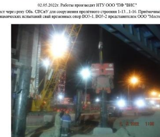
02.05.2022г. Работы производит НТУ ООО "ТФ "ВНС" Мост через реку Обь. СДСмУ для сооружения простого строения 1-13...1-16. Приёмочный контроль динамических испытаний свой временных опор ВО3-1, ВО3-2 представителями ООО "Мостовое бюро"
