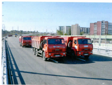
Испытания одного из путепроводов в Перми
