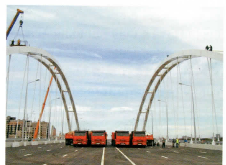
Испытания арочного пролетного строения моста через Ишим в Астане
