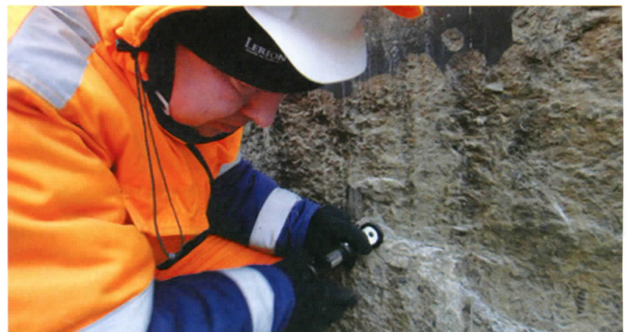
Рис.2. Измерения прочности бетона конструкций и характеристик трещин
