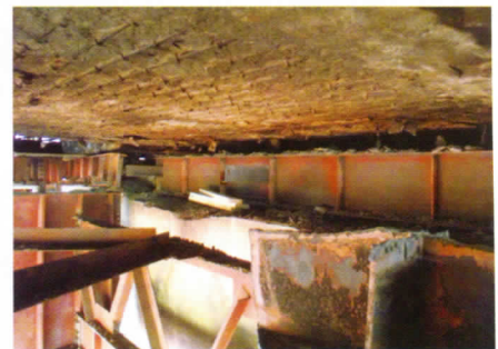
Рис.1. Характерные повреждения бетонных поверхностей пролетного строения
