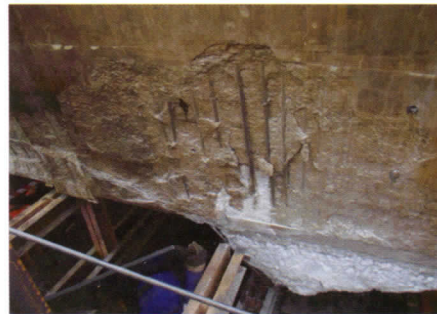
Рис.1. Характерные повреждения бетонных поверхностей пролетного строения
