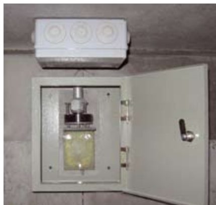
Рис. 5. Инклинометрический датчик в составе системы мониторинга комплекса «Князь Александр Невский»
